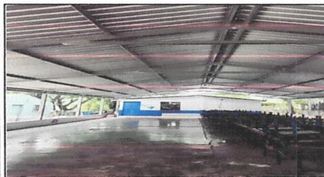
Foto 3: Sustitución de ducto eléctrico + accesorios
